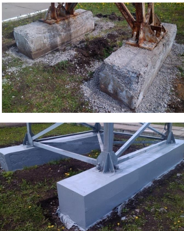
Рис. 3. Восстановление ж/б фундаментов опор ЛЭП с применением бетонополимеров
