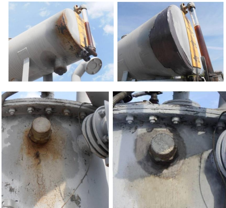
Рис. 1. Устранение течи масла с применением металлополимеров
