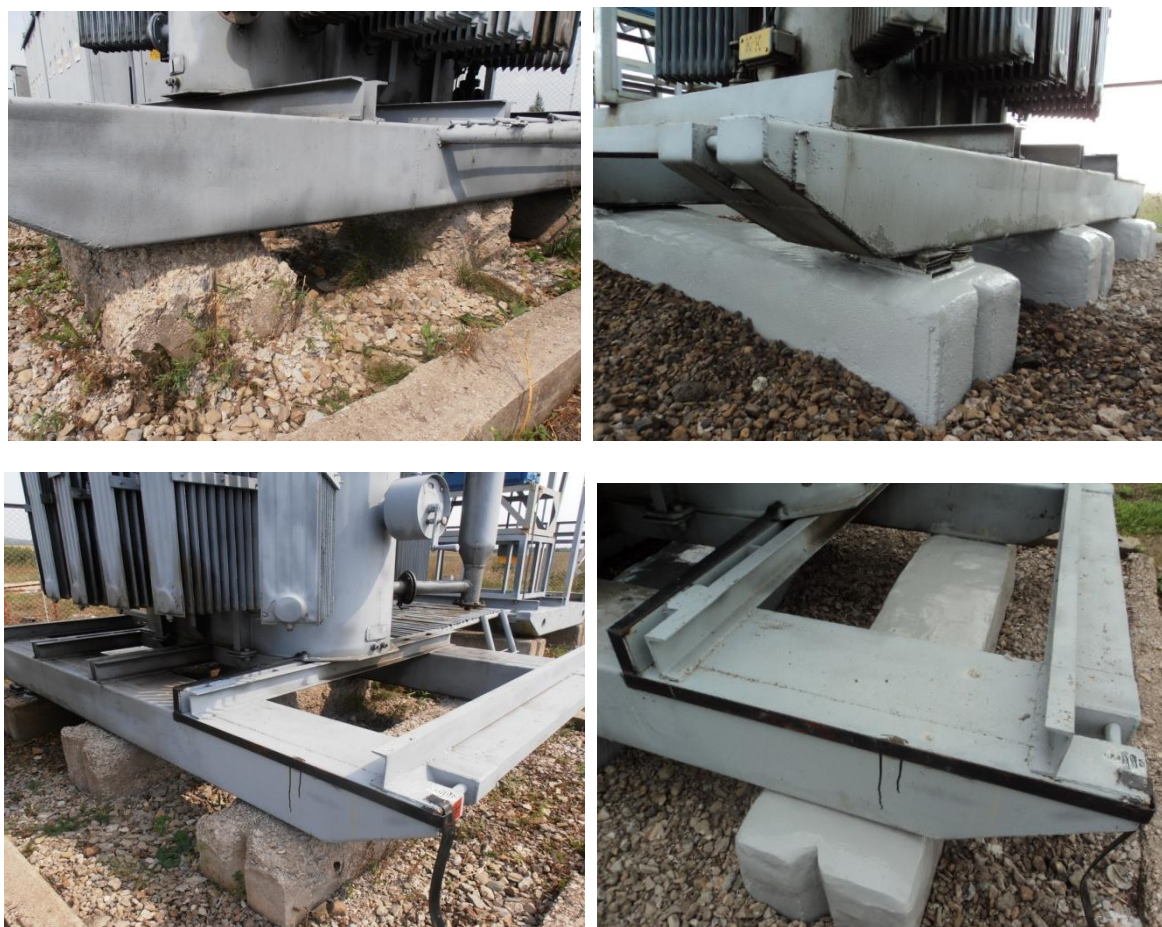
Рис. 2. Восстановление ж/б фундаментов с применением бетонополимеров
